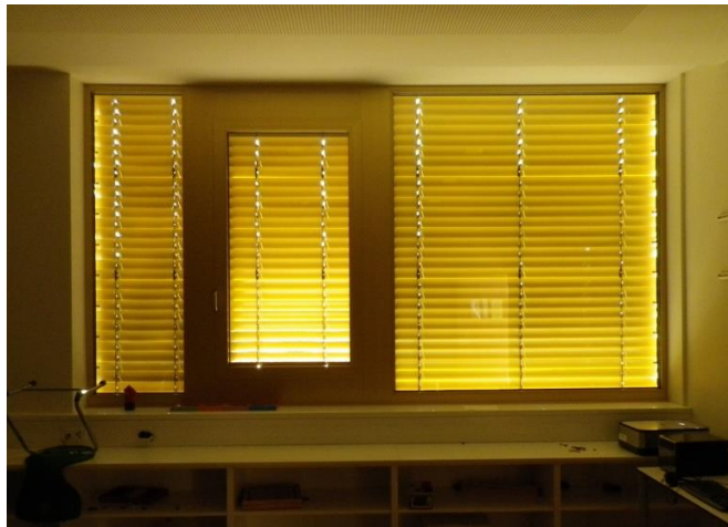
kovové natáčecí lamely vnější žaluzie se stejným sklonem
