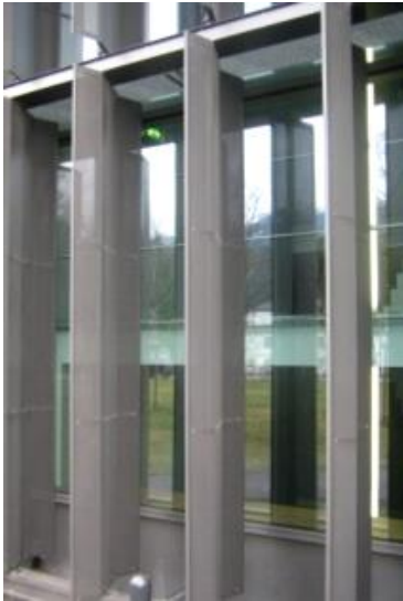
kovové natáčecí lamely vnější žaluzie se stejným sklonem
