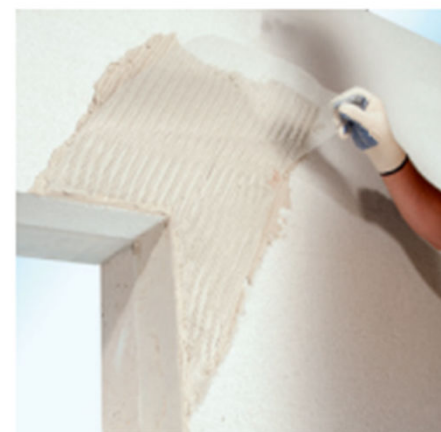
Provádění diagonální výztuže
