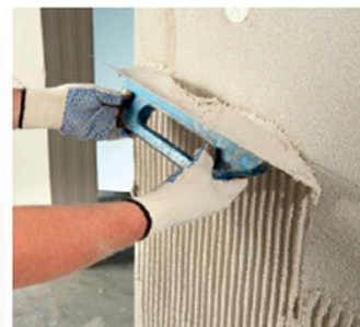
Nanášení první vrstvy Ytong lehčené omítky
