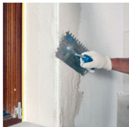
Instalace rohového profilu
